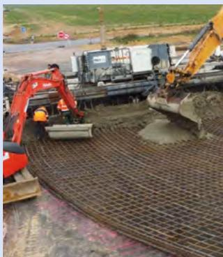
La couche de roulement du giratoire est constituée d'un Béton Armé Continu (BAC) d'une épaisseur de 25 cm reposant sur une couche de forme en granulaire, terminée par une couche en enrobé permettant à la machine de mise en œuvre du béton de circuler. Le BAC est formé de barres d'acier de 20mm de diamètre espacées tous les 18 cm et d'un béton dosé à 400 kg/m<sup>3</sup>, mis en œuvre par une machine permettant de régler le béton sur 10 ml de largeur.
